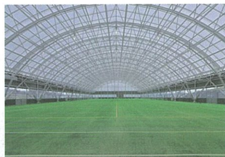
北部スポーツ・レクリエーションパーク屋内運動場
